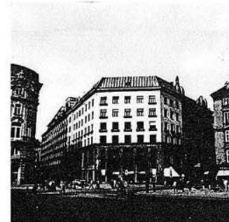
A. Loos: Casa nella Michaelerplatz, Vienna, 1910. Ubicata nella vecchia Vienna la sua nudità dette subito scandalo più di quanto non fece il sanatorio di Purkersdorf di Hoffmann.
