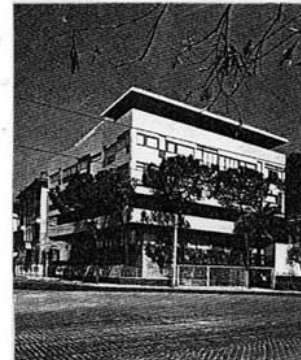
U. Luccichenti, Palazzina in via Paisiello, Roma, 1954. Un purismo teso verso l'espressività linguistica ottimamente intonato nella capitale.
