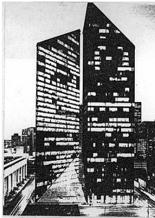
P. Johnson e J. Burgee, Pennzoil Place, Houston, 1976. Due torri che spuntano fuori da una superficie inclinata che le unisce ed una fessura di morettiana memoria. Gambe in punta di piedi verso il cielo.
