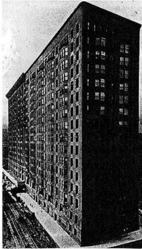
J. Rooth, Monadnock Building, Chicago, 1891. In continuità espressiva con la tecnica muraria si solleva per sedici piani fatti di pareti ondulate ed angoli modellati.
