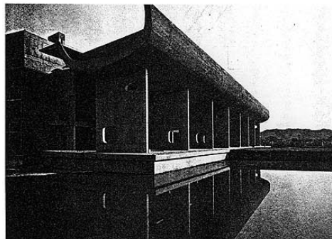
Le Corbusier, Assembly Hall, Chandigarh, 1951. Il brutalismo espressionista è il codice moderno che meglio si confronta con il lungo periodo e con le opere Moghul.
