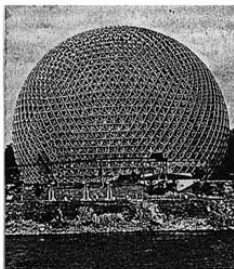
B. Fuller, Cupola Geodesica, Montreal Expo, 1967. Fuller ipotizzò anche la possibilità di coprire intere città con tali strutture e, quindi, di controllarne il clima.
