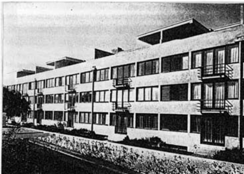
M. Van Der Rohe, Edificio per abitazioni al Weissenhofsiedlung, Stoccarda, 1927. La struttura a scheletro qui dimostra l'alto livello di flessibilità nel taglio degli appartamenti.
