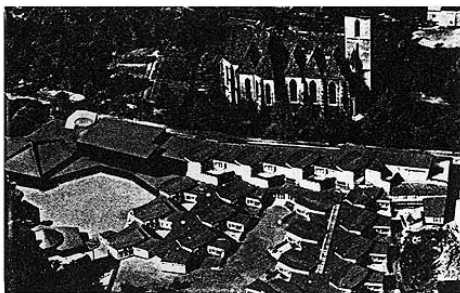
H. Sharoun, Scuola secondaria a Lunen, 1956-62. Perché così e non in mille altri modi se la risposta architettonica è, come in questo caso, eccezionale? Questa è la libertà dell'informale.
