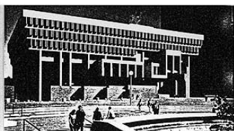
Kallmann, McKinnel, Knowles, Boston City Hall, 1962 - 68. Tourette e Chandigarh, combinati in uno straordinario "oggetto" urbano.
