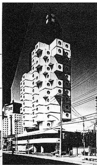
K. Kurokawa, Nakagin Capsule Tower, 1972. Le 144 capsule (washing machines) sono dei monolocali arredati con carenature integrali inserite in un contenitore di C.A. e sono attaccate a due colonne portanti, scala/ascensore. In questo caso il metabolismo dimostra che il codice può operare sia sul territorio linguistico che gli è proprio che su quello delle tecniche della fantasia (straniamento, amplificazione ecc.).
