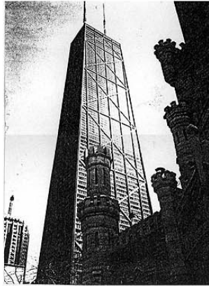
S.O.M., John Hancock Center, Chicago, 1970. L'ossatura esternamente dichiarata è finalmente vera e funzionale alla statica dell'edificio. Da qui il proprio tono prepotente, simbolico ma vero.
