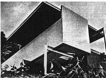
R. Neutra, Brown House, Bel Air, 1955. Gli "outriggers" così come ogni elemento orizzontale e verticale mantengono la propria individualità in un componimento che esalta la sovrapposizione e non l'incastro dei plurimi componenti.
