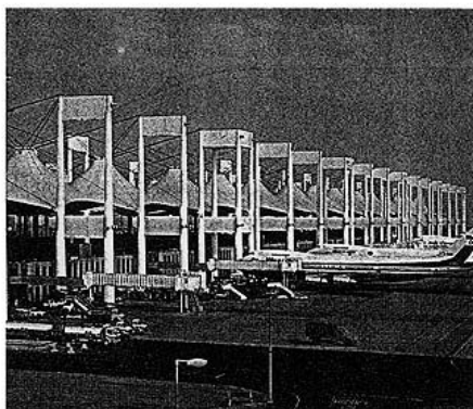
S.O.M. New York & Chicago, King Abdul Aziz International Airport, 1981. Coperture di teflon sorrette da invisibili cavi d'acciaio ancorati a piloni metallici che generano un paesaggio metafisico.
