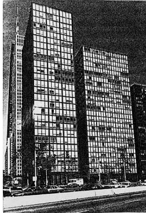
M. Van Der Rohe, Apartment House in Lake Shore dr., Chicago, 1951. Le vetrate sono sostenute da montanti in acciaio che producono un effetto di cangiante plasticità.
